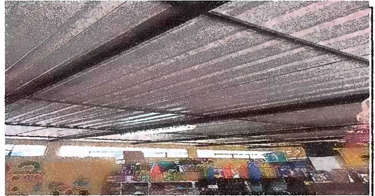
MODULO 2 : FINALIZADO Sustitucion de lamina y mantenimiento de estructura de soporte de metal
