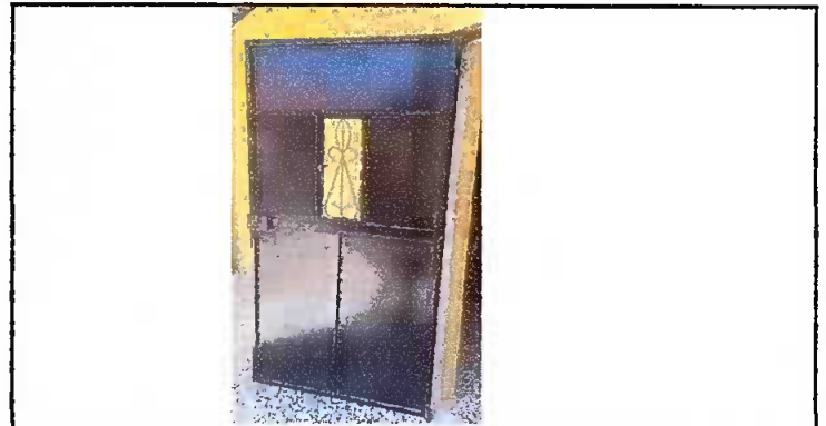
MODULO 3: FINALIZADO Susustitución de puerta
