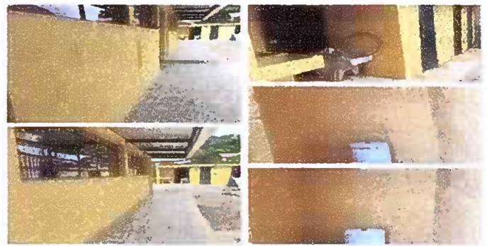
FINALIZADO Pintura en Muros
