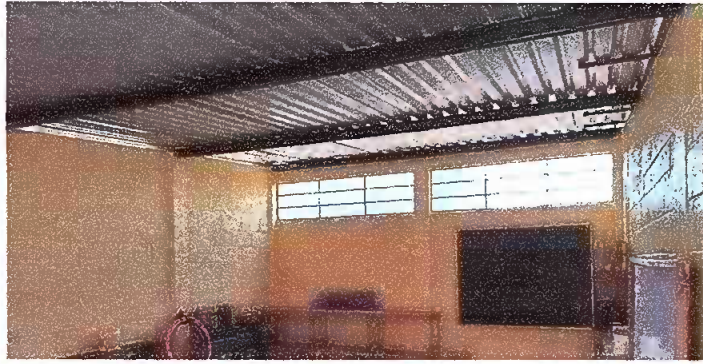
MODULO 1: FINALIZADO Sustitución de lamina y estructura de soporte.
