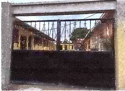
FINALIZADO Sustitución de Portón de Metal
