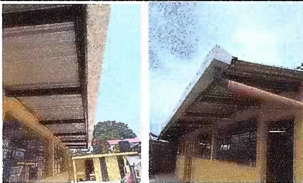
MODULO 2: EN PROCESO Sustitución de canales de metal por pvc.
