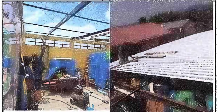
MODULO 2: EN PROCESO SUSTITUCIÓN DE LAMINA Y MANTENIMIENTO DE ESTRUCTURA DE SOPORTE DE METAL
