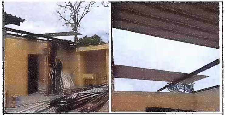
MODULO 3: EN PROCESO SUSTITUCIÓN DE LAMINA Y ESTRUCTURA DE SOPORTE
