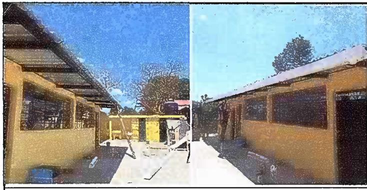
MODULO 2: EN PROCESO SUSTITUCIÓN DE CANALES DE METAL POR PVC
