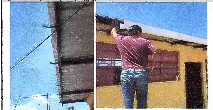
MODULO 1: EN PROCESO SUSTITUCIÓN DE CANALES DE METAL POR PVC
