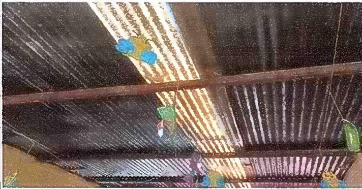
MODULO 1: Sustitucion de lamina y sustitución de estructura de soporte de madera por metal
