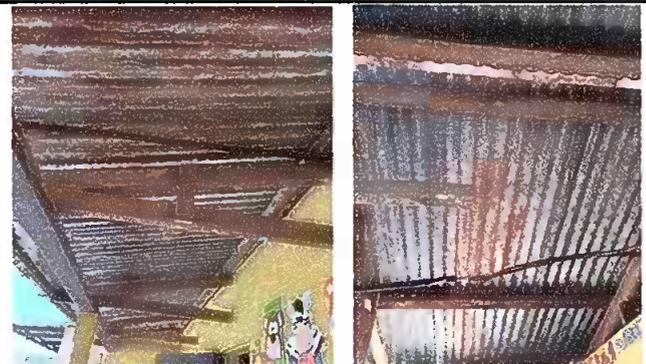
MODULO 3: Sustitución de lamina y sustitución de soporte de madera por metal
