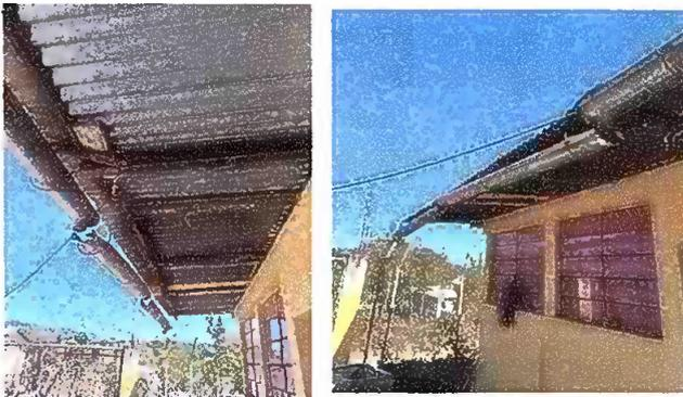
MODULO 1: Sustitucion de canales de metal por canales de PVC
