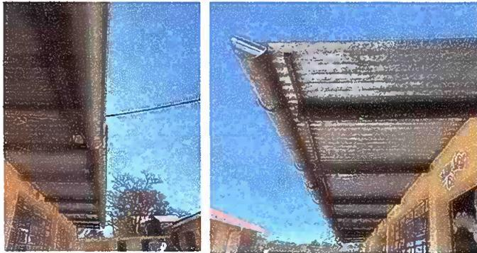
MODULO 2: Sustitucion de canales de metal por PVC
