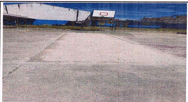
Foto3: MODULO 1: CAMBIO DE TORTA DE CONCRETO
