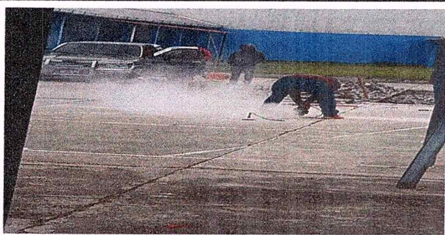
Foto3: MODULO 1: CAMBIO DE TORTA DE CONCRETO
