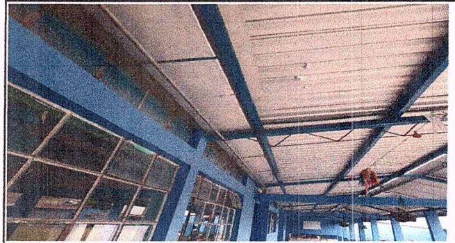
Foto 4: MODULO 1 SUSTITUCION DE CANAL
