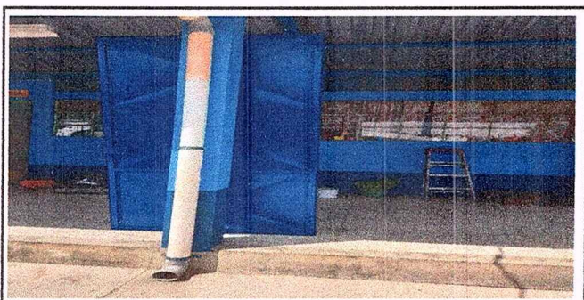
Foto 6: MODULO 1 SUSTITUCIO E INSTALACIÓN DE PUERTAS DE METAL
