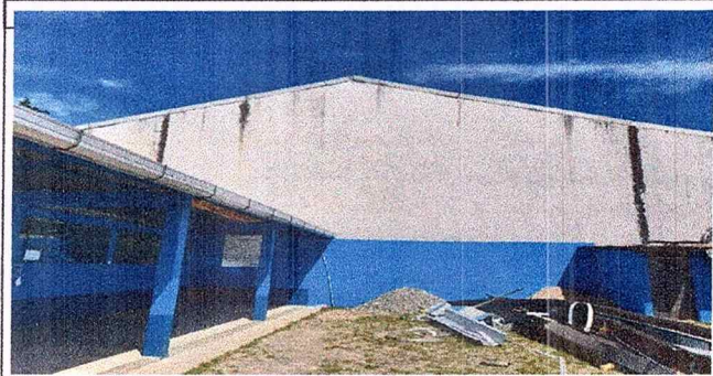
Foto2: MODULO 1: PINTADO EXTERIOR
