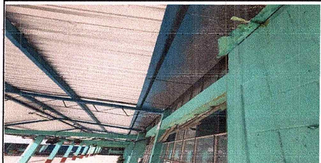
Foto 2 Módulo 1 sustitución de canal
