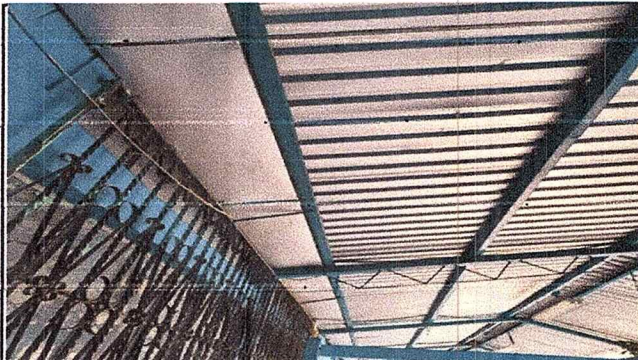
módulo 1 instalación de canal
