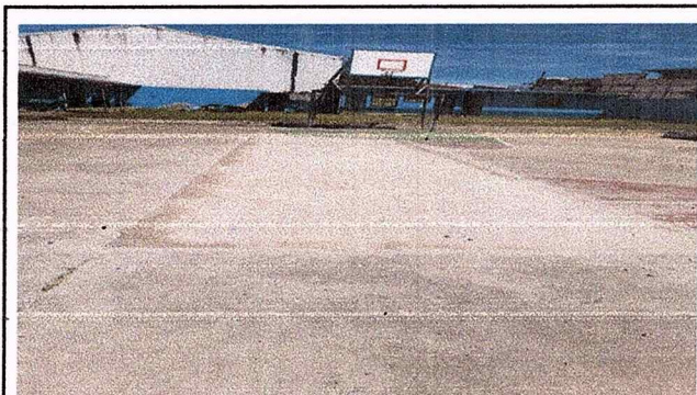
cancha polideportiva: fundición de concreto
