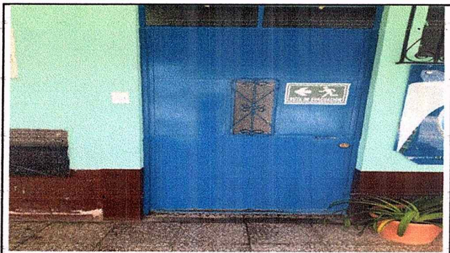
Foto 3: Módulo 2 sustitución de puerta
