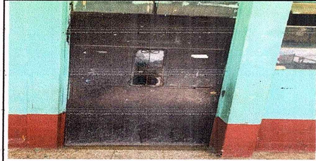
Foto 1 Módulo 1 sustitución de puertas
