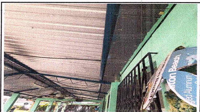
Foto 4: Módulo 2 sustitución de canal
