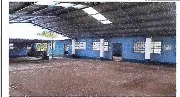
Foto 21: FINALIZADA LA APLICACIÓN DE PINTURA EN EL CORREDOR DEL ESPACIO TECHADO DEL CENTRO EDUCATIVO EORM CANTÓN CHUISIGUAN.
