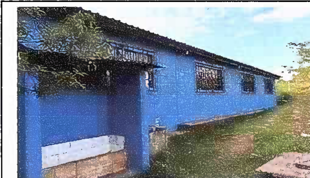
Foto 22: FINALIZADA LA APLICACIÓN DE PINTURA EN LA PARTE EXTERIOR DEL MODULO 3 DEL CENTRO EDUCATIVO EORM CANTÓN CHUISIGUAN.
