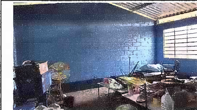
Foto 20: AULA PINTADA DEL MODULO 2 DEL CENTRO EDUCATIVO EORM CANTÓN CHUISIGUAN.
