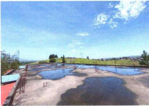
Foto 3: Modulo 6, Impermeabilización de losa
