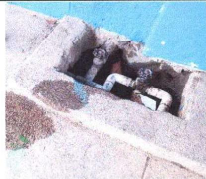
Foto 4 : Modulo 6, Sustitución de llave de cheque
