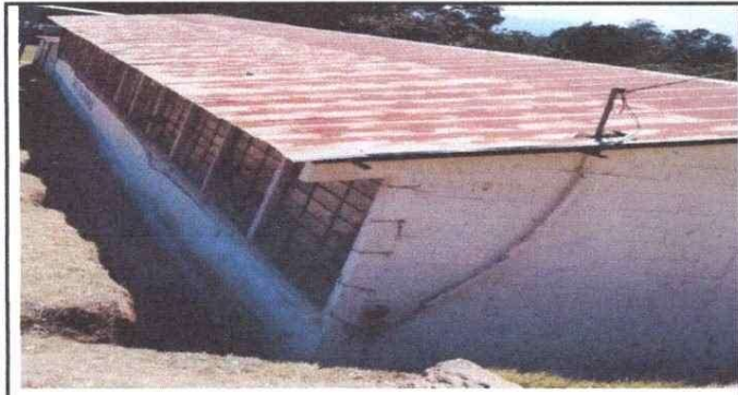
Foto 3: Sustitución de techado
