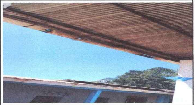
Foto 2: Sustitución de canales de metal
