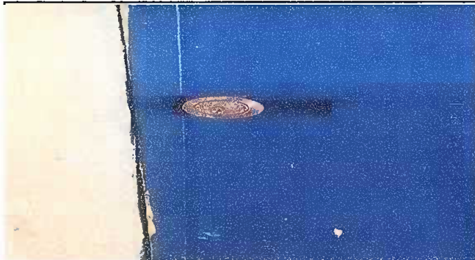
MODULO 3: Foto 9 Sustitución de chapas.
