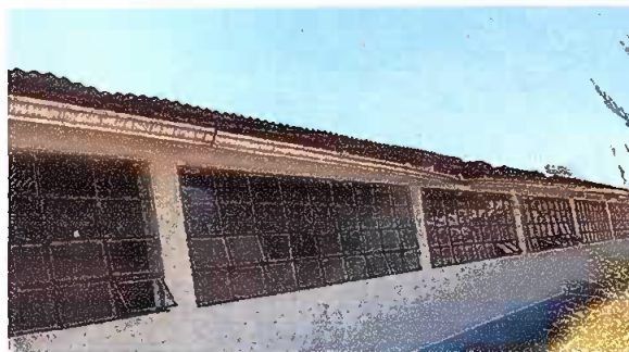
MODULO 3: Foto 10 Sustitución de canal.
