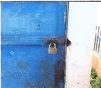
MODULO 4: Foto 11 Sustitución de chapa.
