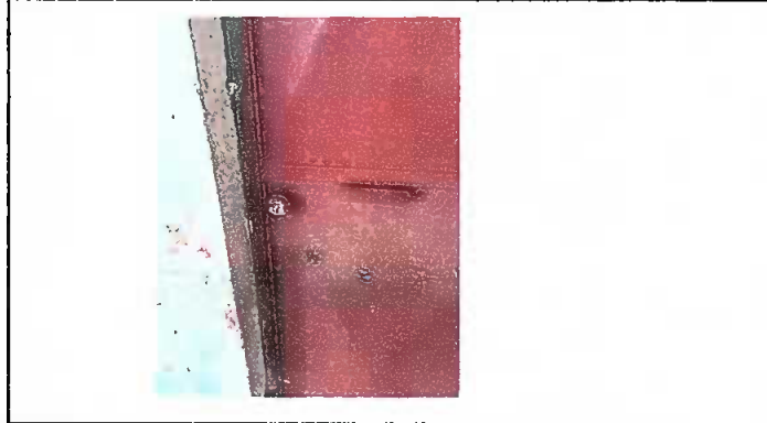
MODULO 1: Foto 2 Sustitucion de chapas.
