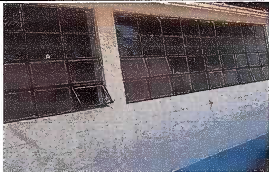
MODULO 2: Foto 7 Sustitucion de balcones de metal.
