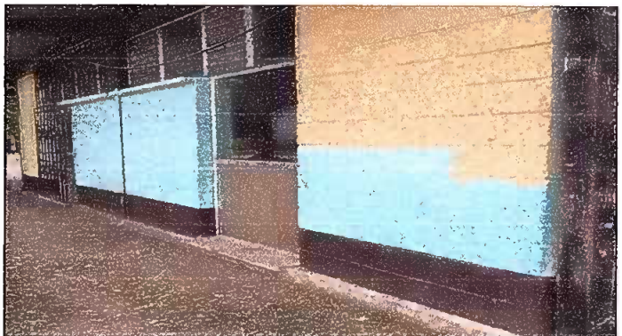
Foto 4: Pintura de modulos antes del proyecto
