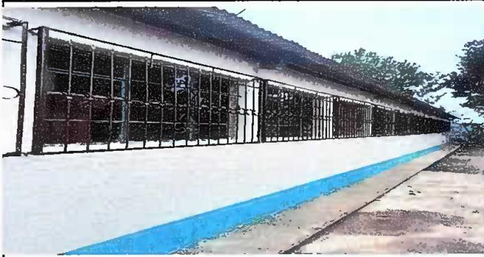
Foto 1: Suministro e instalación de balcones de metal. Módulo 1, 2 y 3
