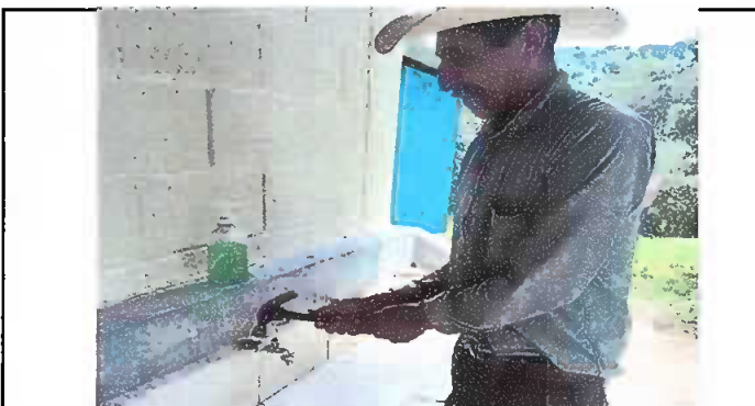
Foto 6: Sustitución de chorros en módulo higiénico. Módulo 4
