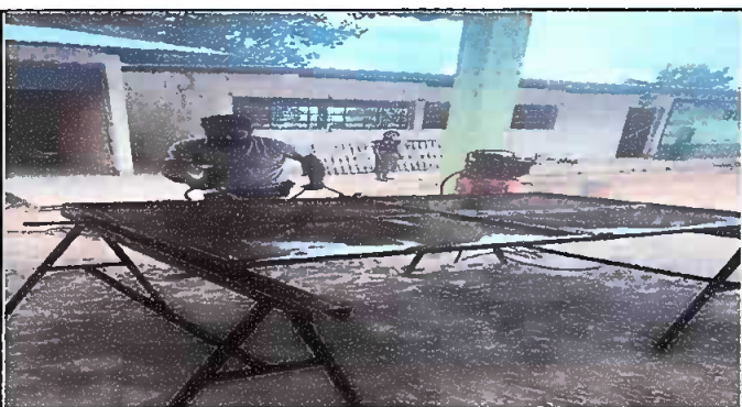
Foto 5: Mantenimiento Pintura de puertas de aulas. Módulo 1, 2 y 3.
