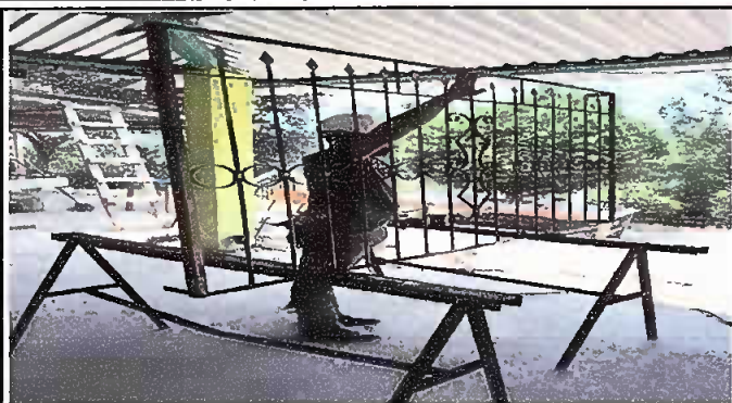
Foto1: Suministro e instalación de balcones de metal. Módulo 1, 2 y 3
