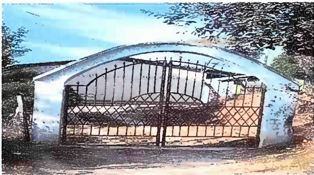
Foto 3: pintura de portón principal. Módulo 5
