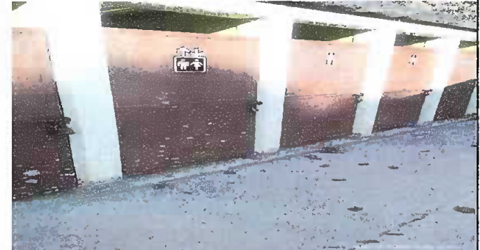
Foto 4: Pintura de puertas de sanitarios. Módulo 4
