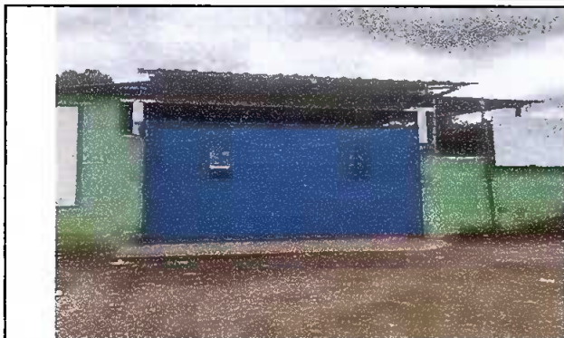
Foto 1: MODULO 1 SUSTITUCION DE PORTON DE MALLA POR POTON DE METAL
