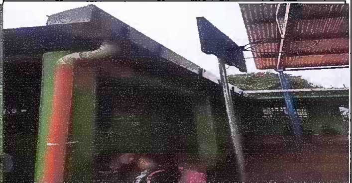
Foto 10: MODULO 4 SUSTITUCION DE CANALES PVC.
