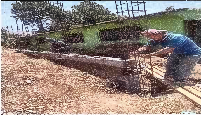
FOTO: 9 MODULO 4 REPARACION DE MURO PERIMETRAL DE BLOK
