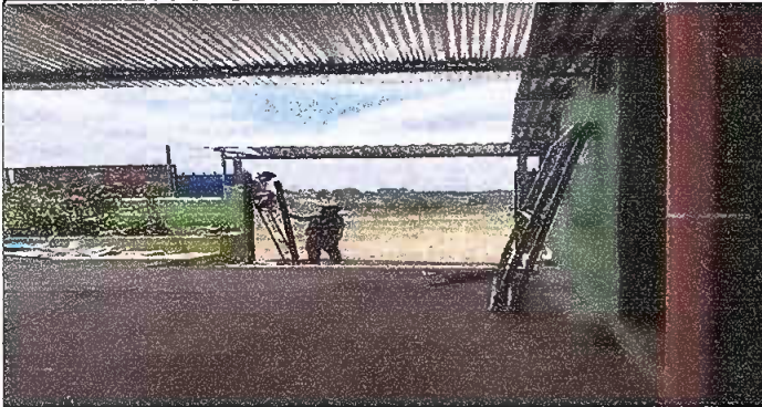
Foto 1: MODULO 1 SUSTITUCION DE PORTON DE MALLA POR POTON DE METAL
