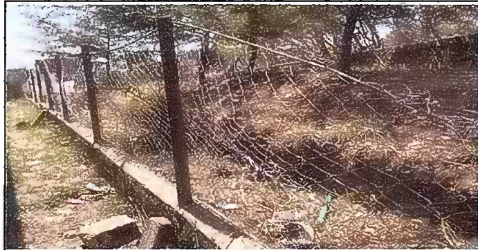
Foto 9: Módulo 4. Reparación de Muro Perimetral de Block.
