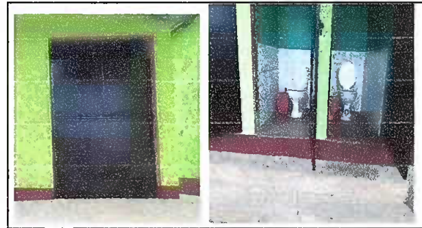
Módulo2: Sustitución puertas de metal en módulos y sustitución de inodoro
