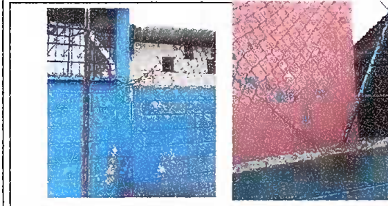
Muro Perimetral: Reparación de tubo hg y malla galvanizada
