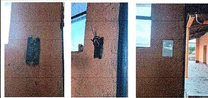
Foto1: modulo I, Reparacion del cableado electrico, sustitucion de ducto electrico mas accesorios, sustitución de lamparas led y instalaciones de unidades de luz.
