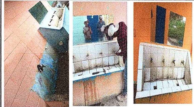
Foto 26 : modulo III,Sustitucion e instalacion de llaves de chorros.
