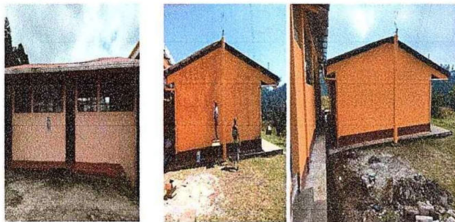
Foto 29 : modulo III, Pintura de muros, interiores y exteriores.
