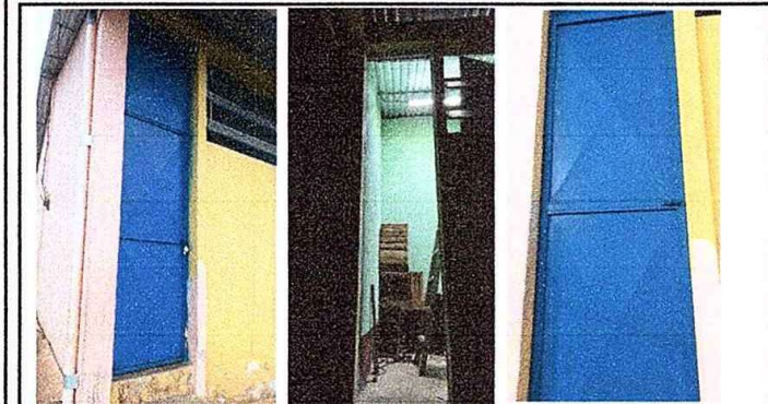
Foto 13: modulo II, sustitucion de puerta
