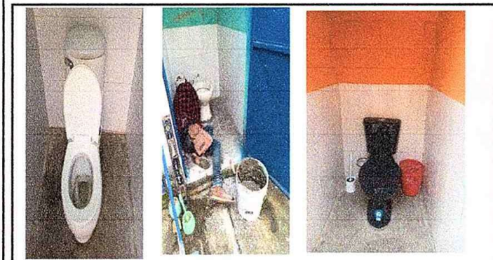
Foto 15: modulo II, Sustitucion e instalacion de inodoros
