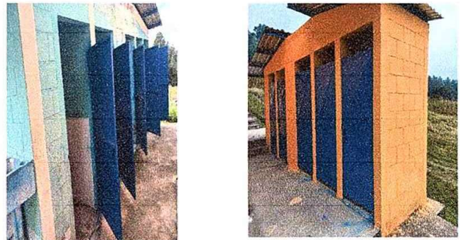
Foto 22: modulo III, mantenimiento de puertas (lijado, cambio de tubo, cepillado, sujeciones.) Aplicaciones de pintura a puertas de servicios
