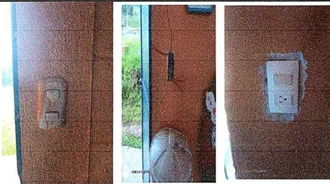
Foto 21: modulo III, Instalacion de unidades de interruptores dobles.
