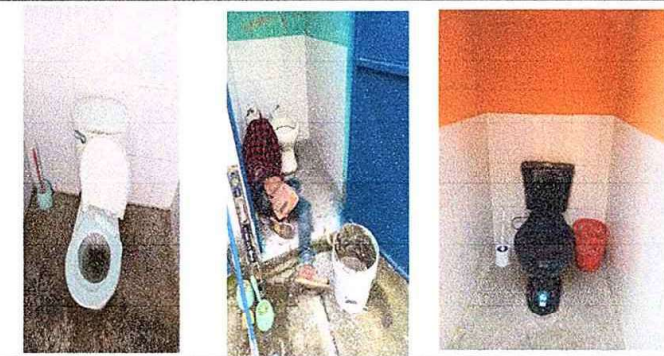
Foto 23: modulo III, Sustitucion e inastalacion de inodoros.
