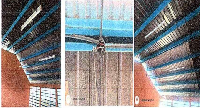
Foto 19: modulo III, Reparacion de cableado electrico, sustitucion de ducto electrico mas accesorios, sustitucion de lamparas led e instalacion de unidades de luz.
