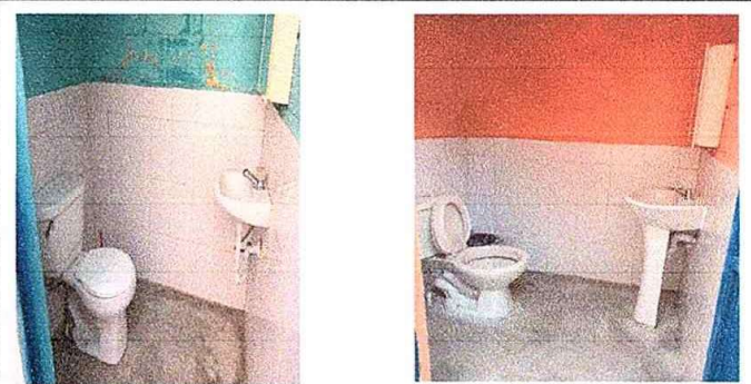
Foto 24: modulo III, sustitucion e instalacion de lava manos.
