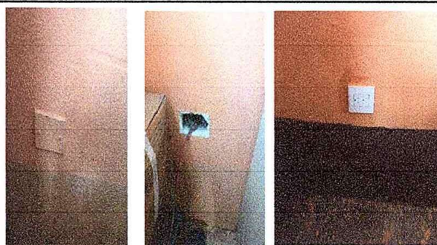
Foto 10: modulo II, Sustitucion de toma corrientes.
