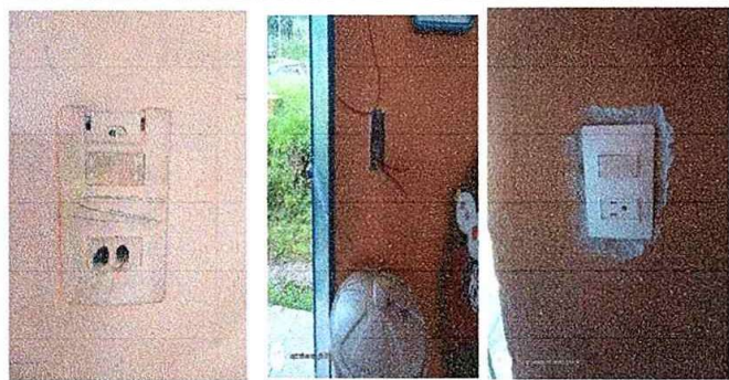
Foto 11: modulo II, Instalacion de interruptores dobles
