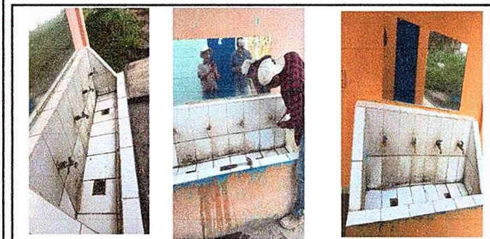
Foto 17: modulo II, Sustitucion e instalacion de chorros.
