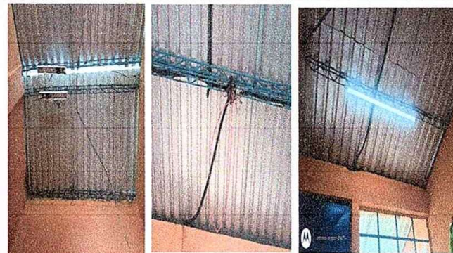
Foto 8: modulo II, Reparación de cableado electrico, sustitucion de ducto electrico mas accesorios, sustituciones de lamparas led e instalaciones de unidades de luz.
