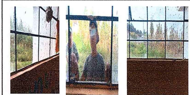
Foto 6: modulo I, Sustitución de vidrio.
