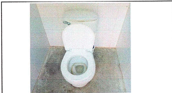
Foto 15: modulo II, Sustitucion e instalacion de inodoros
