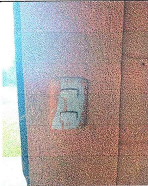
Foto 21: modulo III, Instalacion de unidades de interruptores dobles.
