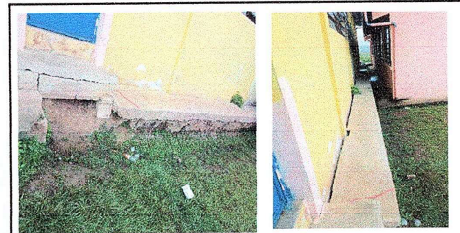
Foto 18: modulo II, Reparacio de banqueta concreto (incluye muro pineado)
