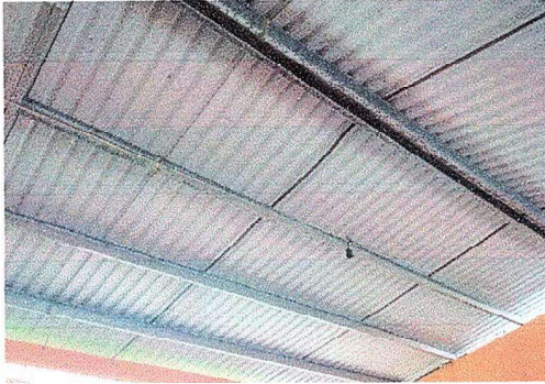
Foto 1: modulo I, Reparación del cableado electrico, sustitucion de ducto electrico mas accesorios, sustitución de lamparas led y instalaciones de unidades de luz.
