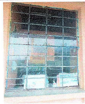
Foto 12: modulo II, sustitucion de estructura de metal de ventana y sustitucion de vidrios
