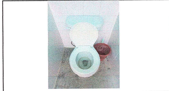
Foto 16: modulo II, Sustitucion e instalacion de inodoros.
