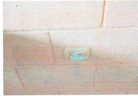
Foto 20: modulo III, Sustitucion de toma corrientes.
