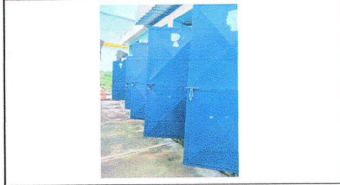
Foto 14: modulo II, mantenimiento de puertas (lijado, cambio de tubo, cepillado, sujeciones.) Aplicaciones de pintura a puertas de servicios
