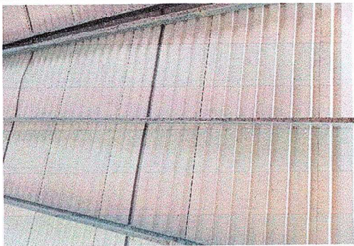
Foto 5: modulo I, Cubierta de Lamina Sustitucion de lamina por lamina troquelada aluzinc calibre 26, elementos de fijación (tornillos), desinstalacion e instalación.
