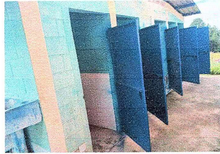
Foto 22: modulo III, mantenimiento de puertas (lijado, cambio de tubo, cepillado, sujeciones.) Aplicaciones de pintura a puertas de servicios
