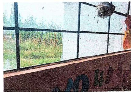
Foto 6: modulo I, Sustitución de vidrio.
