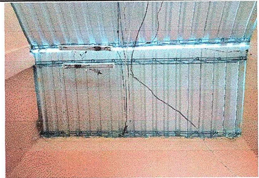
Foto 8: modulo II, Reparación de cableado electrico, sustitucion de ducto electrico mas accesorios, sustituciones de lamparas led e instalaciones de unidades de luz.
