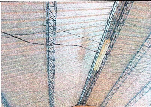
Foto 9: modulo II, Reparación de cableado electrico, sustitucion de ducto electrico mas accesorios, sustituciones de lamparas led e instalaciones de unidades de luz.
