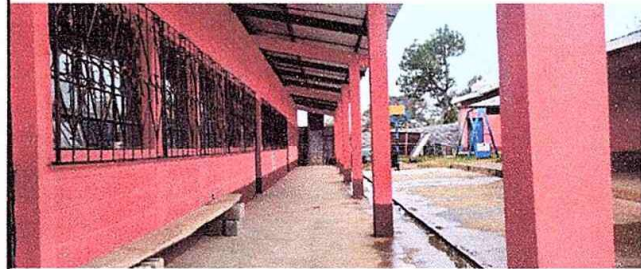
Foto 4: Pintura exteriores e interiores
