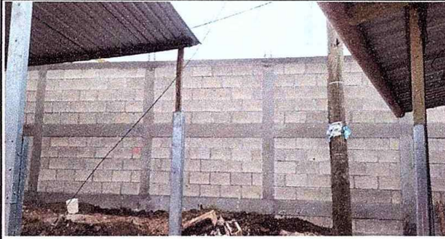
Foto 1: Muro perimetral, reparación de muro perimetral de Block
