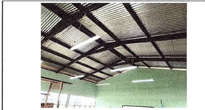
Foto 3 (DURANTE) : Sustitución de lamparas LED
