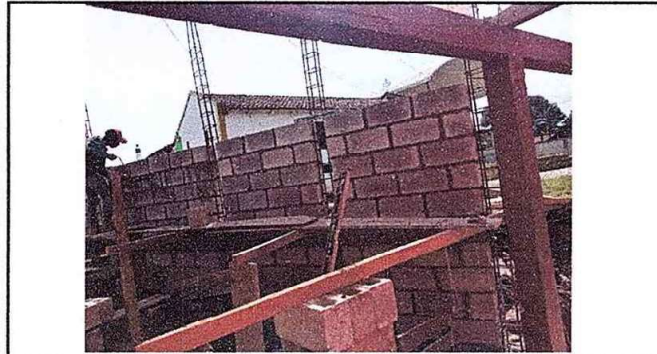
Foto 1 (DURANTE): Muro perimetral, reparación de muro perimetral de Block
