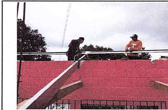
Foto 2 (DURANTE): Sustitución de lamina y sustitución de estructura de soporte de madera por metal
