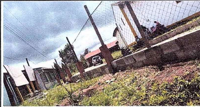
Foto 1: Muro perimetral, reparación de muro perimetral de Block
