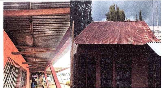
Foto 2: MODULO 1. Sustitución de lamina y sustitución de estructura de soporte de madera por metal
