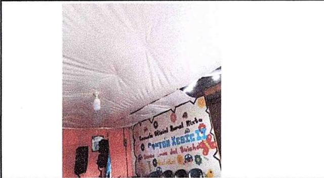
Foto 3: MODULO 1. Sustitución de lamparas LED, en la dirección
