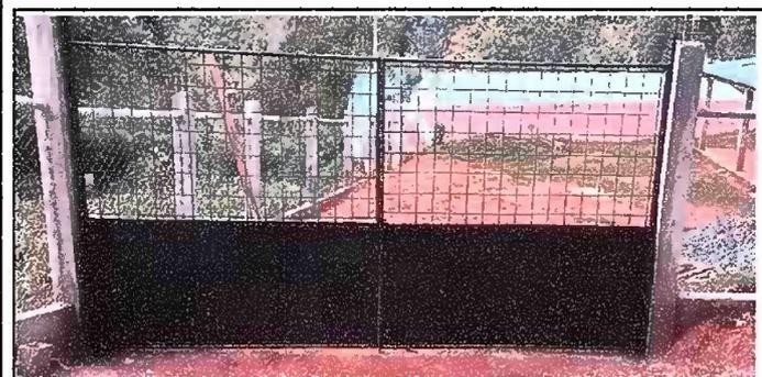
Foto 5: sustitucion de lamina por porton de metal
