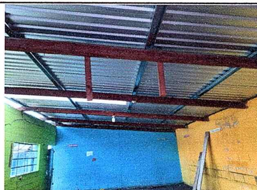
Foto 10: Sustitución de estructura de soporte de madera por metal, módulo No. 1
