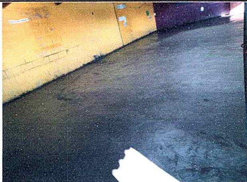
Foto 5: Reparación de piso de cemento liquido, módulo No. 1
