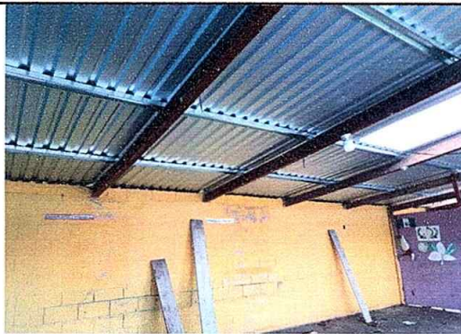
Foto 9: Sustitución de estructura de soporte de madera por metal, módulo No. 1
