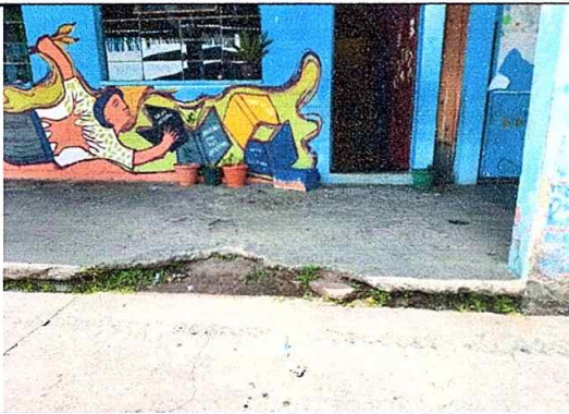
Foto 3: Reparación de banquetas de concreto, módulo No. 1
