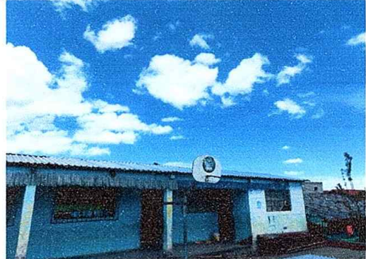
Foto 2: Sustitución de lámina, por lámina troquelada aluzinc calibre 26, módulo No. 2
