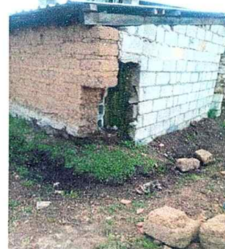
Foto 8: Reparación de muro de block de baño, módulo 3
