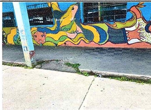
Foto 4: Reparación de banquetas de concreto, módulo No. 1
