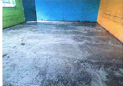
Foto 6: Reparación de piso de cemento liquido, módulo No. 1
