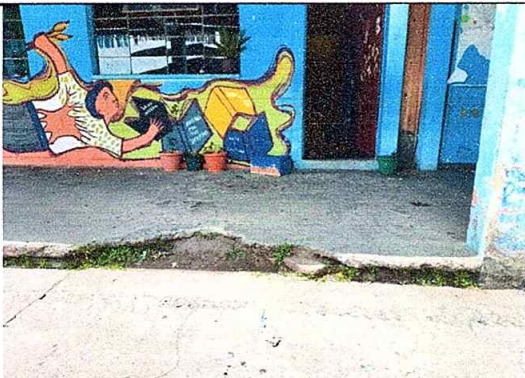
Foto 3: Reparación de banquetas de concreto, módulo No. 1
