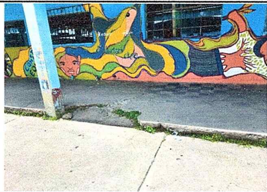
Foto 4: Reparación de banquetas de concreto, módulo No. 1
