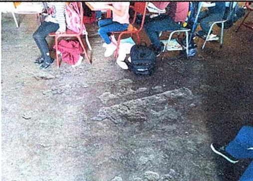
Foto 5: Reparación de piso de cemento liquido, módulo No. 1
