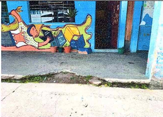
Foto 3: Reparación de banquetas de concreto, módulo No. 1
