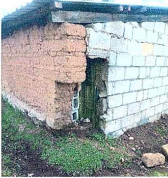
Foto 7: Reparación de muro de block de baño, módulo 3
