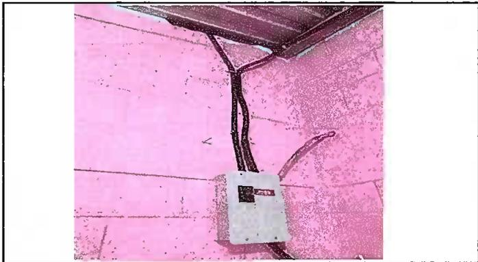
Foto 10: Sustitucion de cable de nergia electrica en las aulas asi mismo sustitucion de focos . Predio 1 y 2
