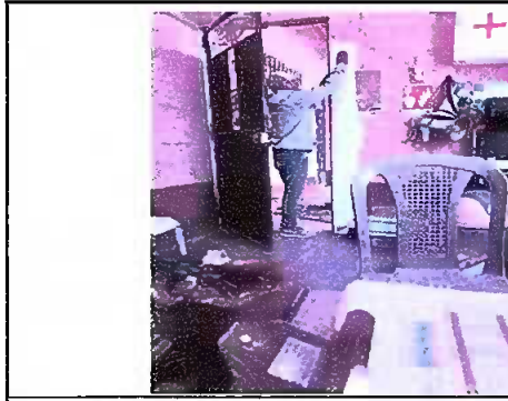
Foto 4: Mantenimiento de 11 puertas. Predio 1 y 2
