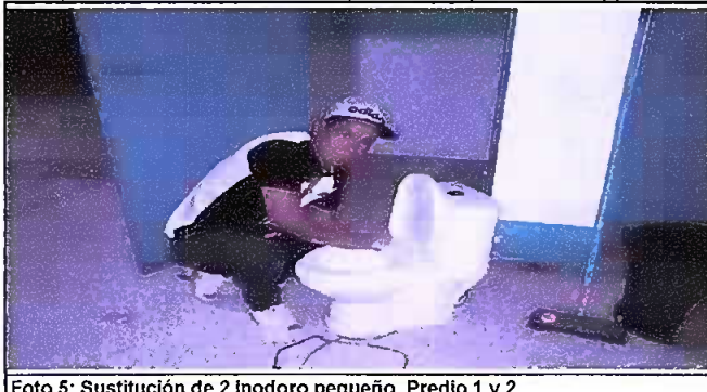
Foto 5: Sustitución de 2 inodoro pequeño. Predio 1 y 2
