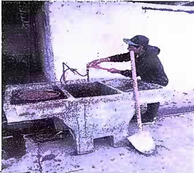
Foto 7: Sustitución de pila de cemento. Predio 1
