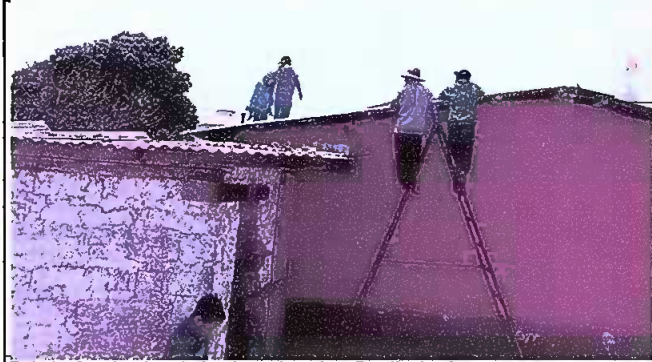
Foto1: Sustitucion de laminas de aulas. Predio 1 y 2
