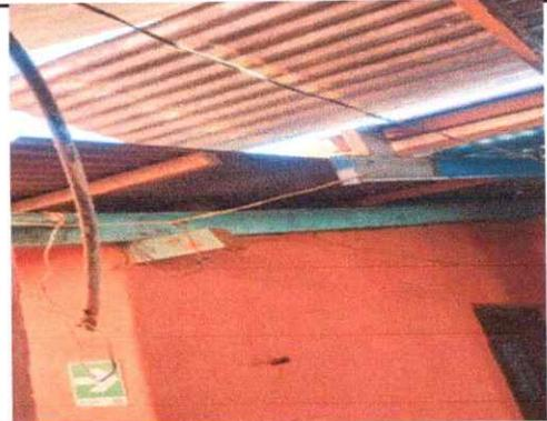
Foto 10: Sustrucion de cable de nergia electrica en las aulas asi mismo sustrucion de focos . Predio 1 y 2
