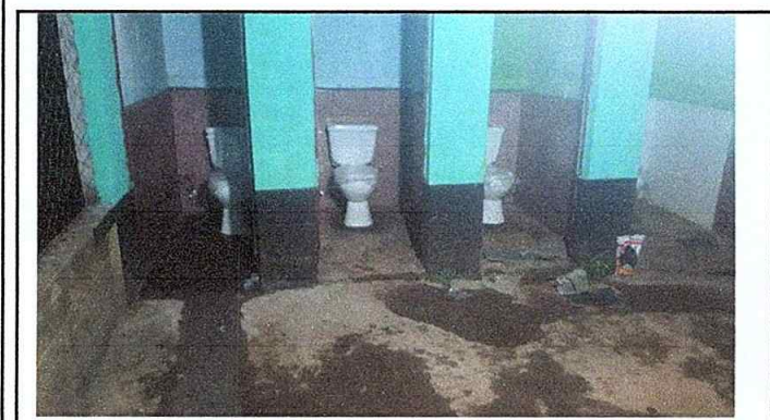
Foto 9: Modulo 2. Sustitución de inodoro.
