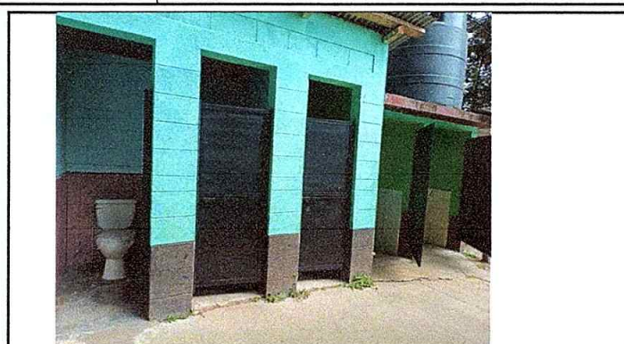
Foto 8: Modulo 2. Mantenimiento a estructura de puerta.
