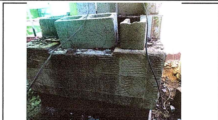
Foto7: Modulo 1. Reparación de azulejo en muebles de concretode cocina.
