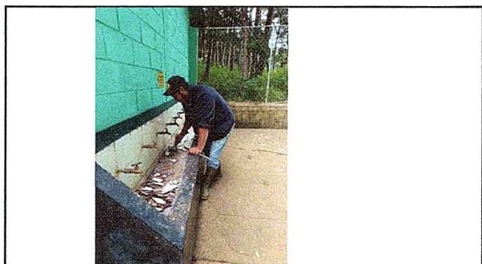
Foto 10: Modulo 2. Sustitución de azulejo.
