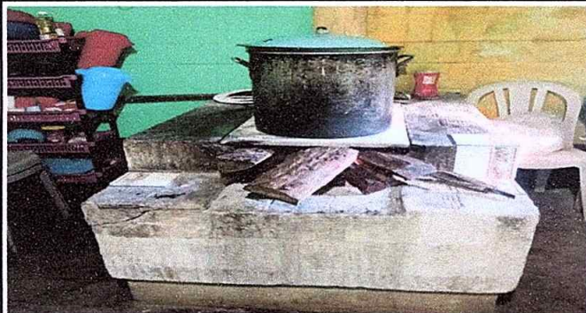
Foto7: Modulo 1. Reparación de azulejo en muebles de concretode cocina.
