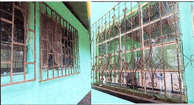
Foto 5: Modulo 1. mantenimiento a balcones de metal.
