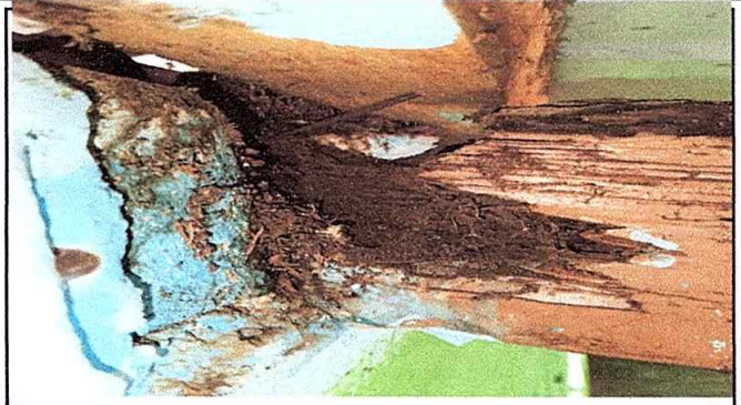
Foto 2: Modulo 1. Sustitución de vigas
