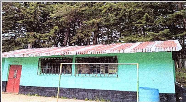
Foto1: Modulo 1. Sustitución de lamina
