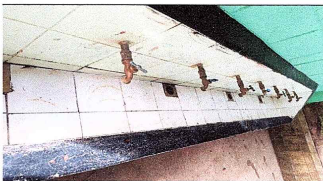
Foto 10: Modulo 2. Sustitución de azulejo.
