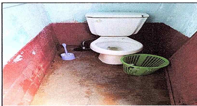
Foto 9: Modulo 2. Sustitución de inodoro.
