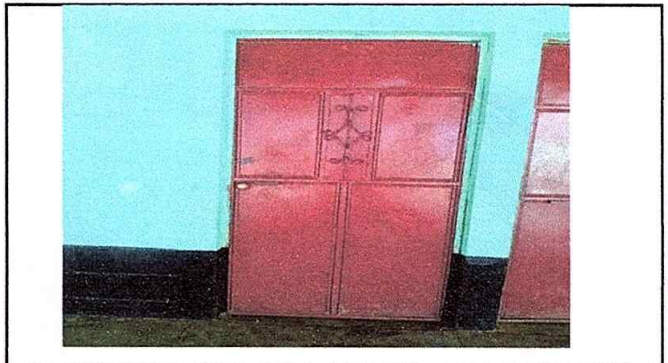
Foto 4: Mantenimiento a estructura de puerta.
