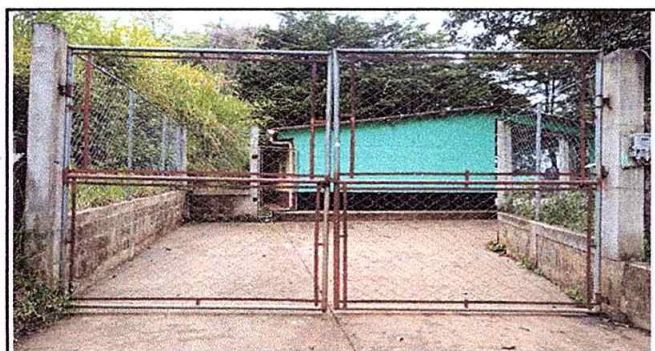
Foto 11: Muro perimetral: Sustitución de porton de metal. Suministro de estructura portante de metal. Suministro de lamina troquelada.
