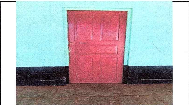
Foto 3: Modulo 1. Sustitución de puertas.
