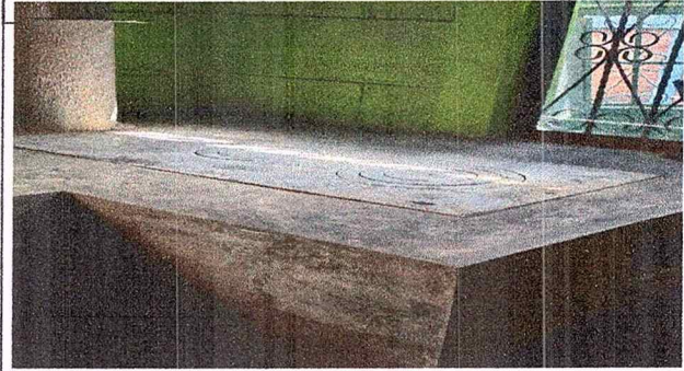
Foto 8: MODULO 1: COCINA SUSTITUCIÓN DE ESTUFA RURAL COMPLETA INCLUYE :CHIMENEA Y PLANCHA DE METAL
