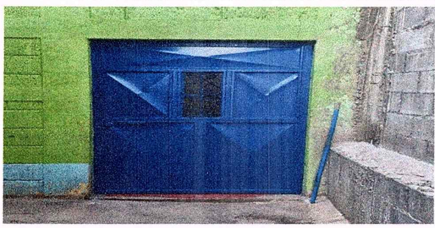
Foto 7: MODULO 1: COCINA SUSTITUCIÓN DE PUERTA DE METAL
