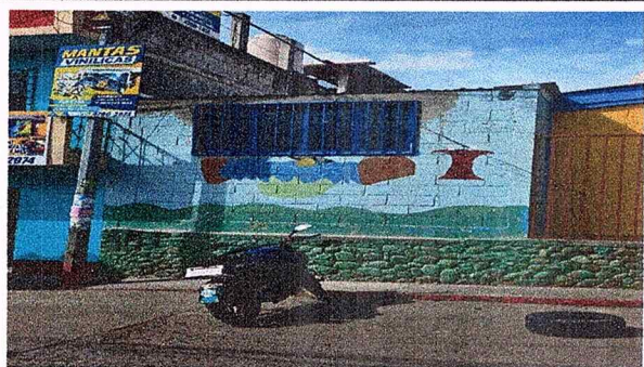
Foto1: MODULO 1: Apertura más tallado de vanos en ventanas. Suministro e instalación de ventanas de metal. Suministro e instalación de balcones de hierro en ventanas.
