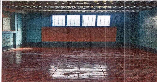
Foto 4: MODULO 1 Sustitución de piso de cemento líquido por piso cerámico.
