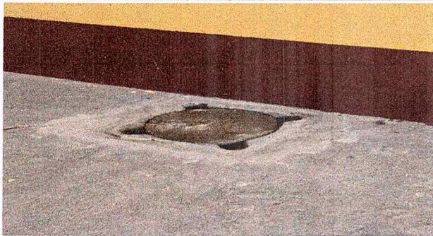
Foto: 9 MODULO 2: SUSTITUCIÓN DE TAPADERA DE DRENAJE
