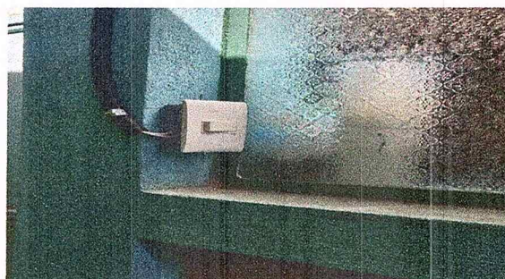
Foto 6: MODULO 1 INSTALACIÓN DE UNIDADES DE LUZ
