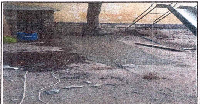
Foto 6: MÓDULO 3 PATIO: REPARACIÓN PLANCHA DE CONCRETO Y REPARACIÓN MURO DE BLOCK
