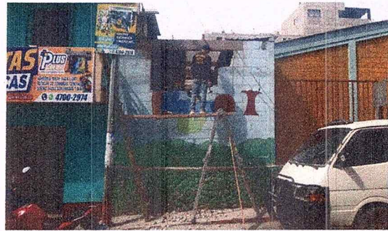
Foto 2: MÓDULO I . APERTURA MÁS TALLADO DE VANOS EN VENTANAS
