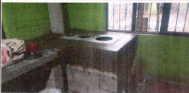
Foto 3: MÓDULO I COCINA. SUSTITUCIÓN DE ESTUFA RURAL
