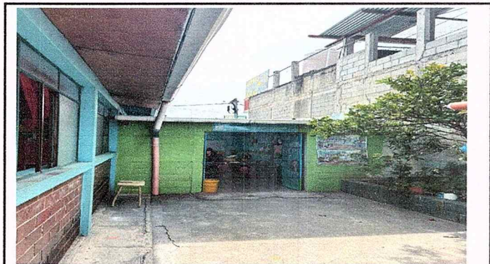
Foto3: MODULO 1: Apertura más tallado de vanos en ventanas. Suministro e instalación de ventanas de metal. Suministro e instalación de balcones de hierro en ventanas.
