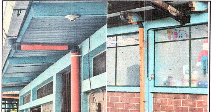
Foto 15 : MODULO 3 PATIO Reparación de cableado eléctrico, sustitución ducto eléctrico más accesorios, Sustitución plafoneras (caja octagonal), Sustitución focos ahorradores, Instalación de unidades de luz.
