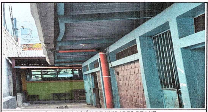
Foto 6: MODULO 1 INSTALACIÓN DE UNIDADES DE LUZ
