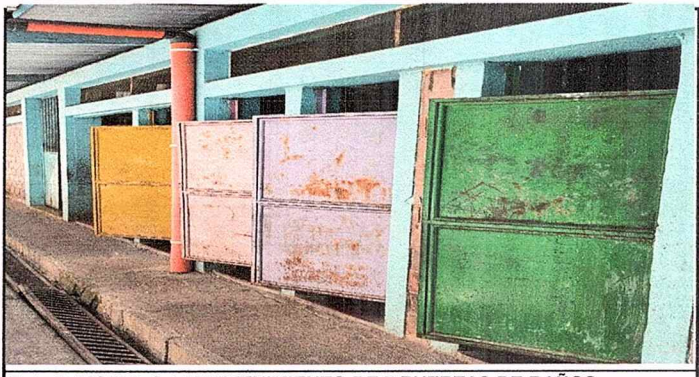
Foto 5: MODULO 1 MANTENIMIENTO DE 7 PUERTAS DE BAÑOS SANITARIOS. Lijado cepillado, aplicación de pintura.
