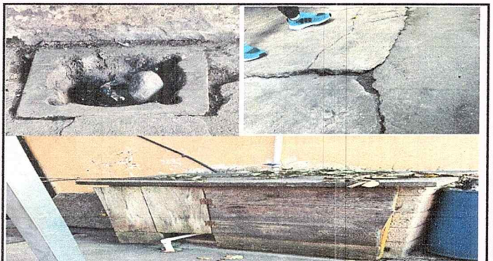
Foto 17: MODULO 3 PATIO SUSTITUCIÓN DE REPOSADERA, REPARACIÓN PLANCHA DE CONCRETO Y REPARACIÓN MURO DE BLOCK, SUMINISTRO E INSTALACIÓN DE PUERTA
