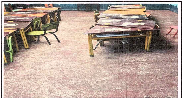
Foto 4: MODULO 1Sustitución de piso de cemento líquido por piso cerámico.
