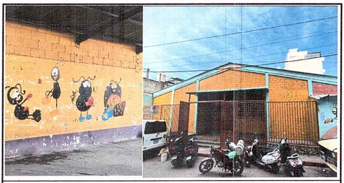
Foto 19: Y PINTURA GENERAL EN MUROS INTERIORES Y EXTERIORES
