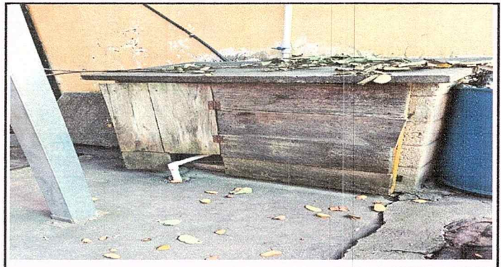
Foto 17: MODULO 3 PATIO REPARACIÓN MURO DE BLOCK, SUMINISTRO E INSTALACIÓN DE PUERTA
