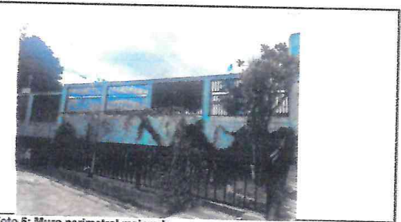
Foto 5: Muro perimetral mejorado
