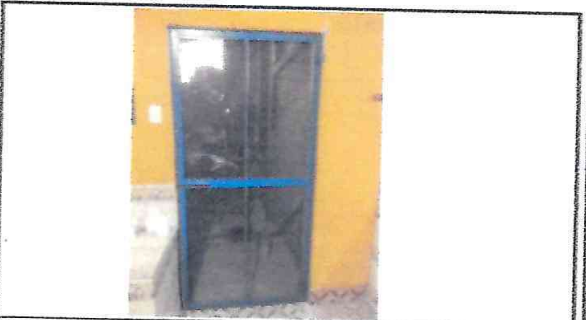
Foto 4: Colocación del cedazo en las puertas
