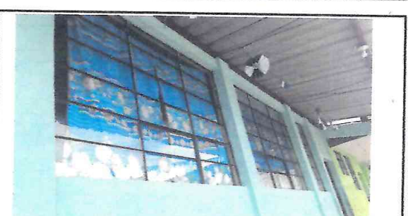
Foto 6: Instalación de balcones en ventanas de aulas por la seguridad de los niños.
