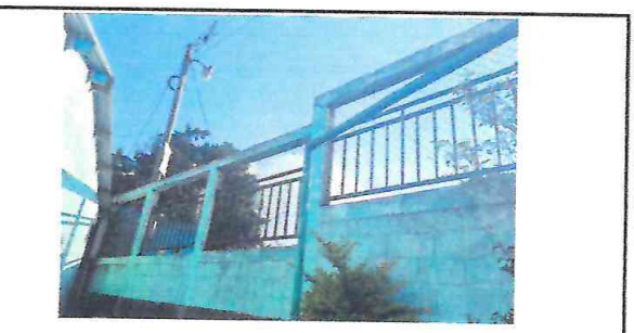
Foto 5: Muro perimetral con rejillas y malla en mal estado, en donde se requiere refuerzo y pintado de las barandas.
