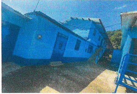
Foto1: MANTENIMIENTO PINTURA EN MUROS EXTERIORES. Aplicación de pintura en aulas por afuera
