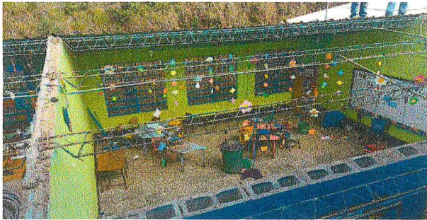
Foto 3: REPARACIÓN /SUSTITUCIÓN/ MANTENIMIENTO DE CUBIERTA DE LÁMINA. Sustitución de lámina, por la lámina troquelada calibre 26
