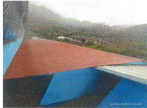
Foto 4: REPARACIÓN /SUSTITUCIÓN/ MANTENIMIENTO DE CUBIERTA DE LÁMINA. Sustitución de lámina, por la lámina troquelada calibre 26
