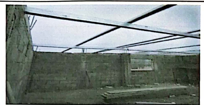
Foto 4: Suministro e instalación de muro y costaneras.
