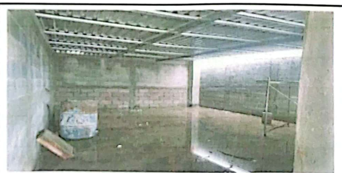
Foto 6: Suministro e instalación de laminas
