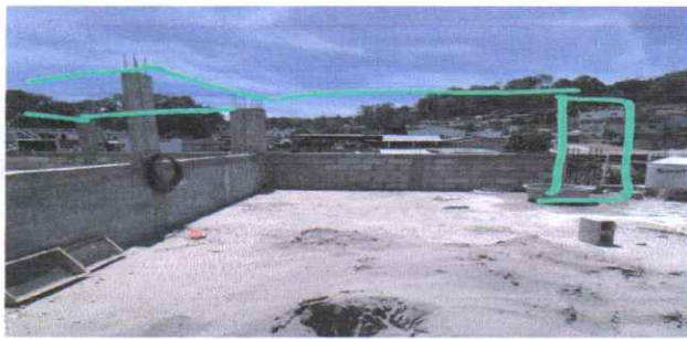
Suministro e instalacion de lamina troquelada calibre 26
