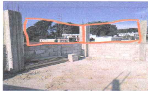
Suministro e instalacion de puerta de metal
