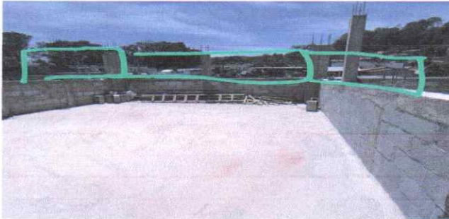
Suministro e instalacion de muro
