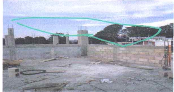
Suministro e instalacion de muro
