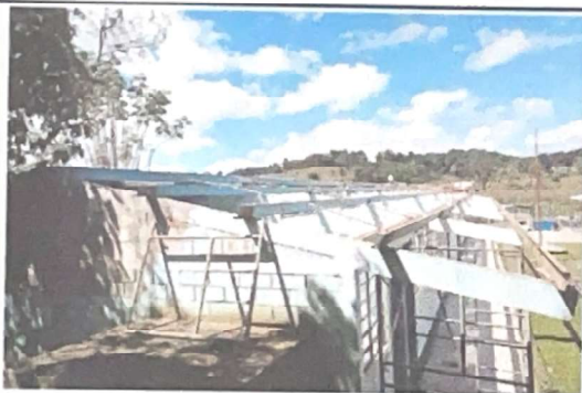
Foto 3: REPARACIÓN/SUSTITUCIÓN MANTENIMIENTO DE CUBIERTA DE LÁMINA. De lámina por la lámina troquelada calibre 26.
