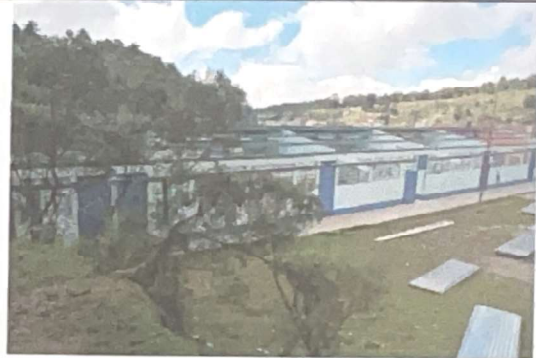
Foto 2: REPARACIÓN/SUSTITUCIÓN MANTENIMIENTO DE CUBIERTA DE LÁMINA. De lámina por la lámina troquelada calibre 26.
