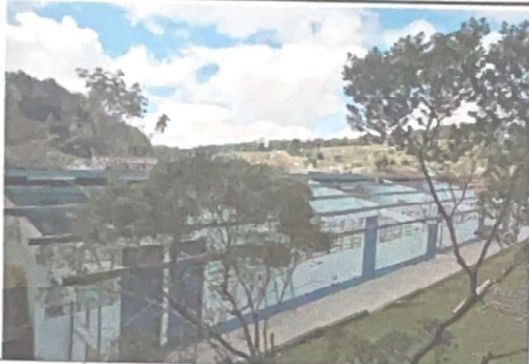
Foto 1: REPARACIÓN/SUSTITUCIÓN MANTENIMIENTO DE CUBIERTA DE LÁMINA. De lámina por la lámina troquelada calibre 26.
