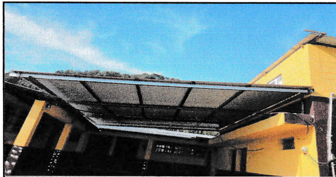
Foto 3: Instalacion de techo.
