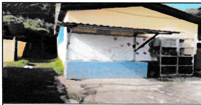
Foto 5: Instalacion de techo en el area de lavamanos.
