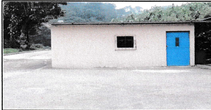
Foto1: Ampliacion de Cocina
