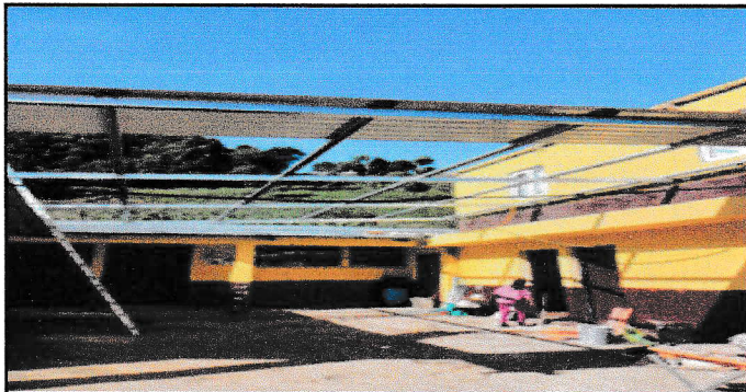
Foto 3: INSTALACION DE TECHO
