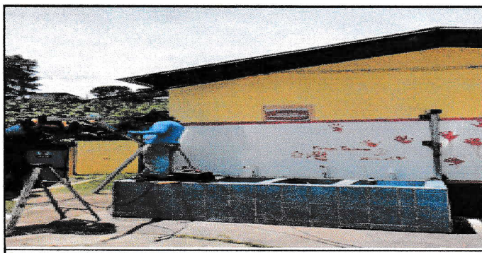
Foto 5: INSTALACION DE TECHO DE AREA DE LAVAMANOS
