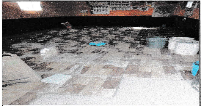
Foto 2: SUMINISTRO E INSTALACION DE PISO CERAMICO
