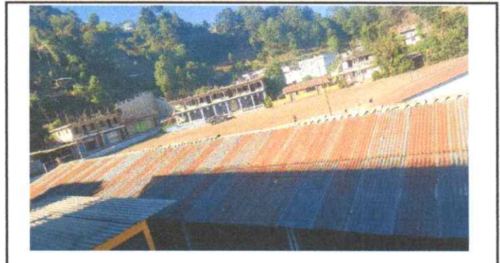
SUMINISTRO E INSTALACION DE PINTURA EN PUERTAS Y TECHO DE LAMINA
