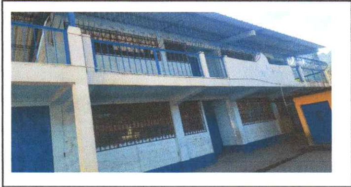
PINTURA DE MUROS Y AULAS
