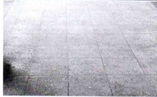
Mantenimiento sustitución de piso de concreto a piso cerámico
