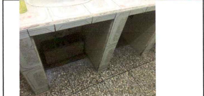
Suministro e instalación de puertas
