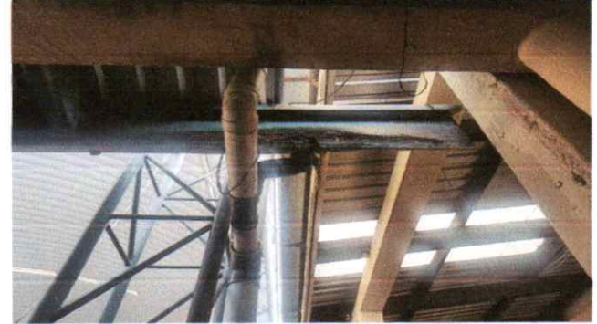
Sustitucion de canal de metal
