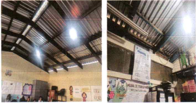
Instalacion de cielo falso en dirección y cuatro aulas
