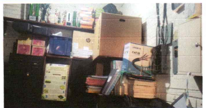
Suministro e instalación de estanteria fija de bodega en dirección
