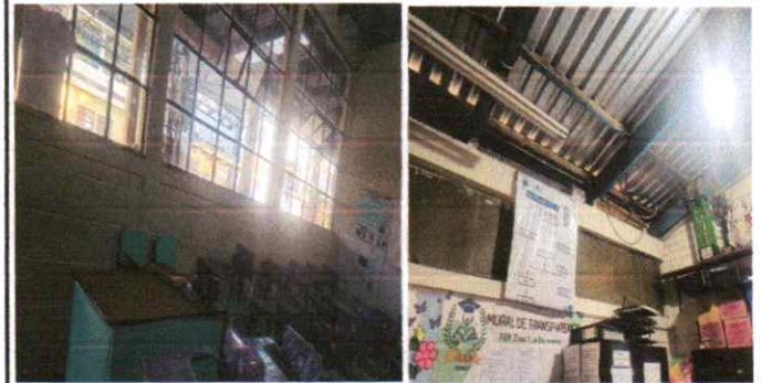
Pintura de aulas y dirección
